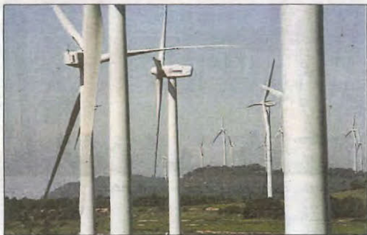
El projecte preveu aixecar nou aerogeneradors a la comarca.
